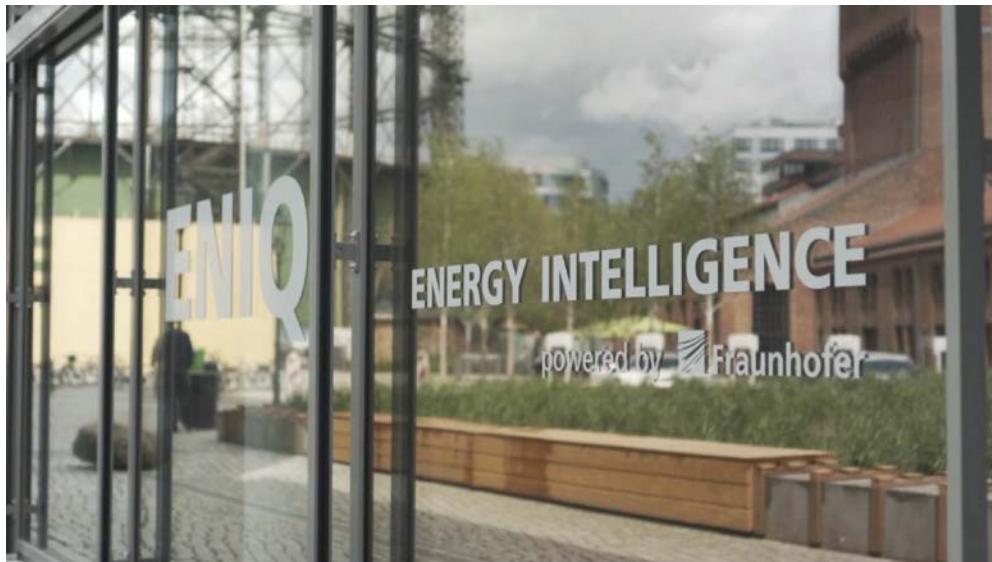
Foto des Gebäudes © Fraunhofer ENIQ
