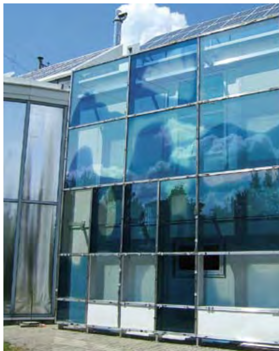
Abb. 2: Gaschrom schaltende Testfassade, Solarhaus Freiburg (Januar 2008).
