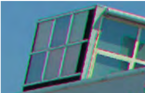
Abb. 2: Die selben Isolierverglasungen wie in Abb. 1 werden hier unter einem Einfallswinkel von 75° betrachtet. Die Farbunterschiede der verschiedenen Produktfamilien sind deutlich zu erkennen. Mit einer Farbmesskamera und der am Fraunhofer ISE entwickelten Mess- und Auswertungsmethode können solche Farbunterschiede quantitativ erfasst werden.
