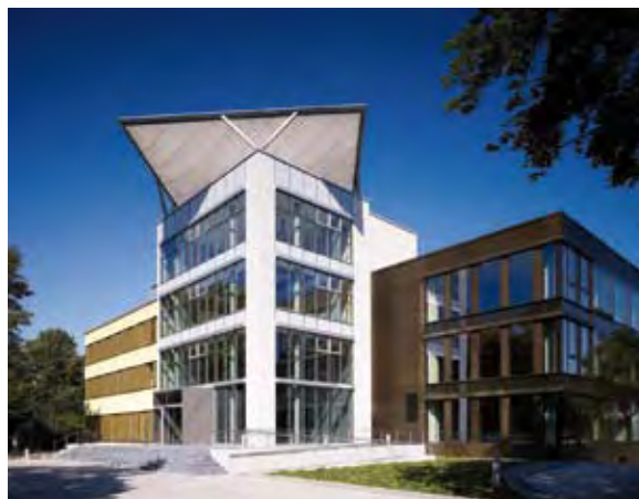
Abb. 1: In der Forschungsplattform »inHaus2« werden innovative Konzepte zur Betriebsführung und -optimierung entwickelt. Das »inHaus2«-Gebäude besteht aus drei Gebäude-segmenten, in denen innovative Wärme- und Kälteübergabesysteme zum Einsatz kommen. Dazu zählen thermoaktive Bauteilsysteme in Form von Betonkern- und Fußboden-temperierung (Foto: Das Fraunhofer-inHaus-Zentrum, ©Fotograf Guido Erbrin).
