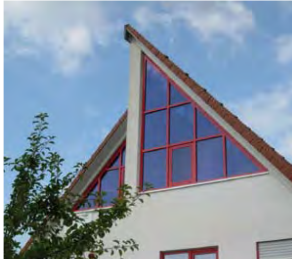
Abb. 1: Gaschrom schaltende Fassade, Gebäude der Firma Werner Herr GmbH, Ebringen (September 2008). Gesamtansicht im geschalteten Zustand aus Richtung Südwest.
