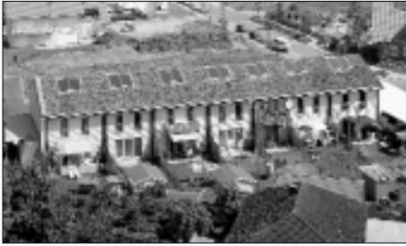
Abb. 1: Ansicht Solar-Passivhäuser Neuenburg.
