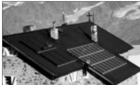
Abb. 1: Photovoltaikanlage und Kollektoranlage auf dem Süddach des Brandenburger Hauses, der mit 3 277 Meter über dem Meer höchst gelegenen Hütte des Deutschen Alpenvereins.
