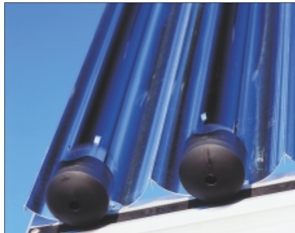
Abb. 2: Detailphoto eines Vakuumröhrenkollektors mit externem Reflektor.
