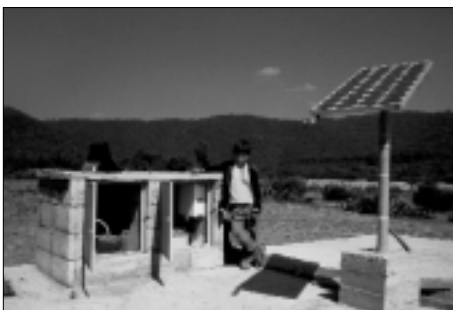
Abb. 2: San Antonio de Agua Bendiat in Mexiko: Trinkwasser-Desinfektion mittels einer PV-betriebenen Elektrolysezelle.
