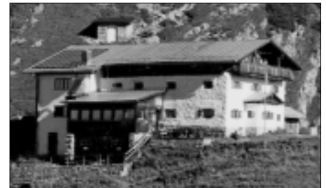
Abb. 2: Tölzer Hütte auf 1 825 Meter über Meer. Hier decken 35 m 2 Solarfläche mit 3,5 kWp Leistung und ein 750 Watt Windgenerator den gesamten Strombedarf.
