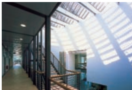
Abb. 3: Ein Blick die Shed-Dach-Konstruktion des Atriums, mit integrierter Photovoltaik.
