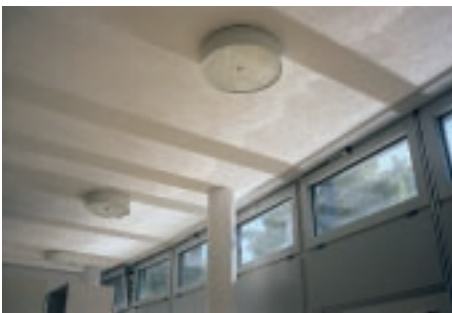
Abb. 1: Beispiel der Wirkung einer lichtlenkenden Verglasung, die von existierenden Simulationswerkzeugen nicht berechnet werden kann.
