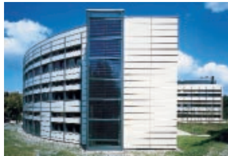
Abb. 1: In die Fassade der »Magistrale« ist ein 2,4 kWp PV Generator integriert.
