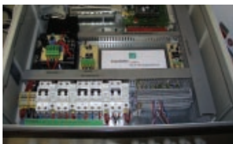
Abb. 2: Realisierte Elektronik des Energiemanagementsystems zur Steuerung von Hybridsystemen.
