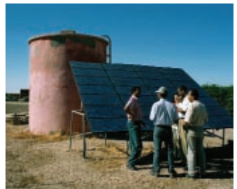
Abb. 1: PV-betriebene Wasserversorgung in Efert, Marokko mit integrierter Desinfektion. In Zukunft soll das Dorf zusätzlich mit einem PV-betriebenen Mini-Stromnetz versorgt werden.
