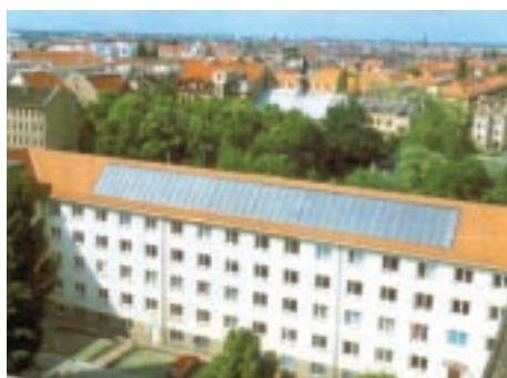
Abb. 1: Anlage mit großer Kollektorfläche im Mehrgeschosswohnungsbau, Solarthermie 2000 Programm.
