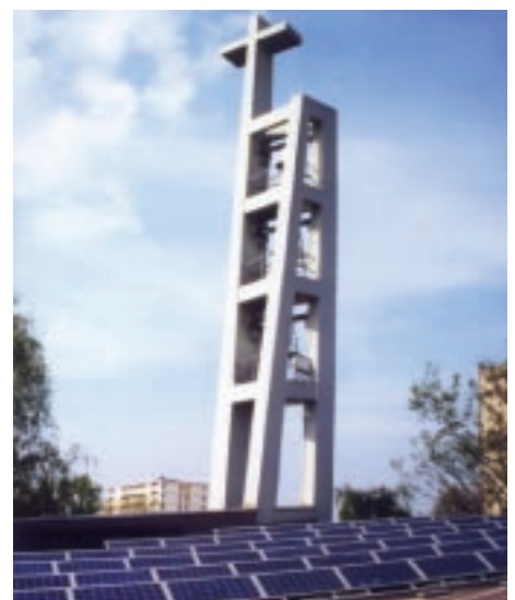
Abb. 3: Die Anlage der Katholischen Studentengemeinde in Berlin liegt mit einem spezifischen Jahresertrag von 680 kWh/kWp erheblich unter dem Durchschnittswert.
