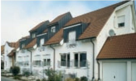
Kleine Passiv-Reihenhauszeile in Ötigheim.
