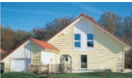
Frei stehendes Passivhaus in Bretzfeld.
