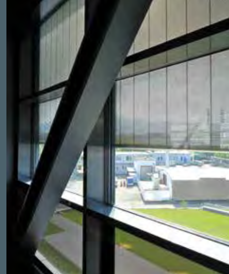
Laborneubau Fraunhofer ISE: Seminarraum mit bauwerksintegrierter Photovoltaik (BIPV) – teil-transparente PV-Module mit winkelselektiver Transmission (PV Shade®).
